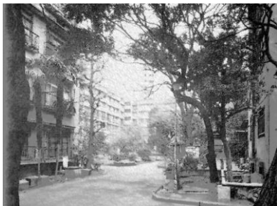
中庭を囲む建物(解体前 平成15年撮影)
