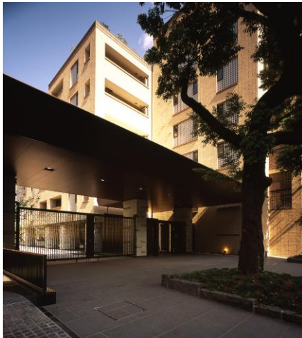
エントランス ファサードとキャピラー
