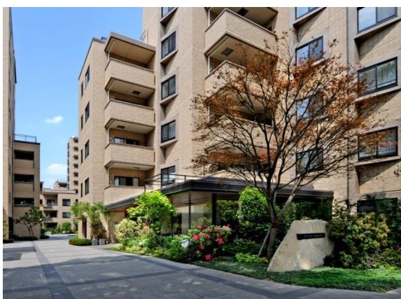
国領住宅建替計画 エントランスH インフォर्मーションロビー外観
